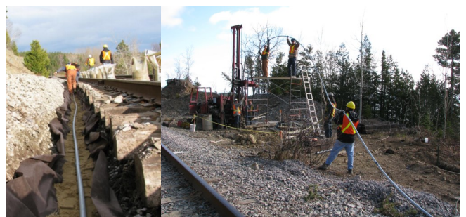
Fig.2 SAA+PVC手法による水平設置、鉛直設置
