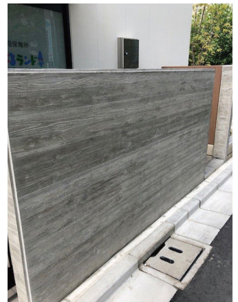
「ライジングコート」の施工例 コンクリート打ち放し壁面を補修し、 木目調に仕上げ
