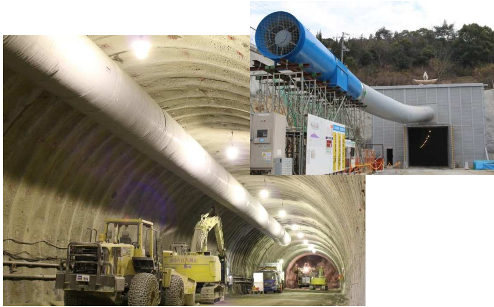
写真-1 導入現場の電気機器（工事照明、換気ファン）
