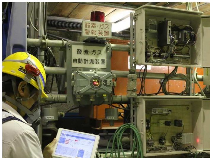
写真-2 トンネル内の制御機器・iPadでの閲覧・操作
