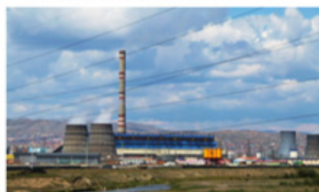
発電機の振動監視システム更新
