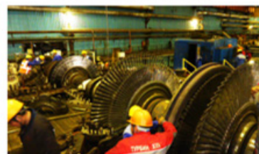
発電所の試運転立ち合い
